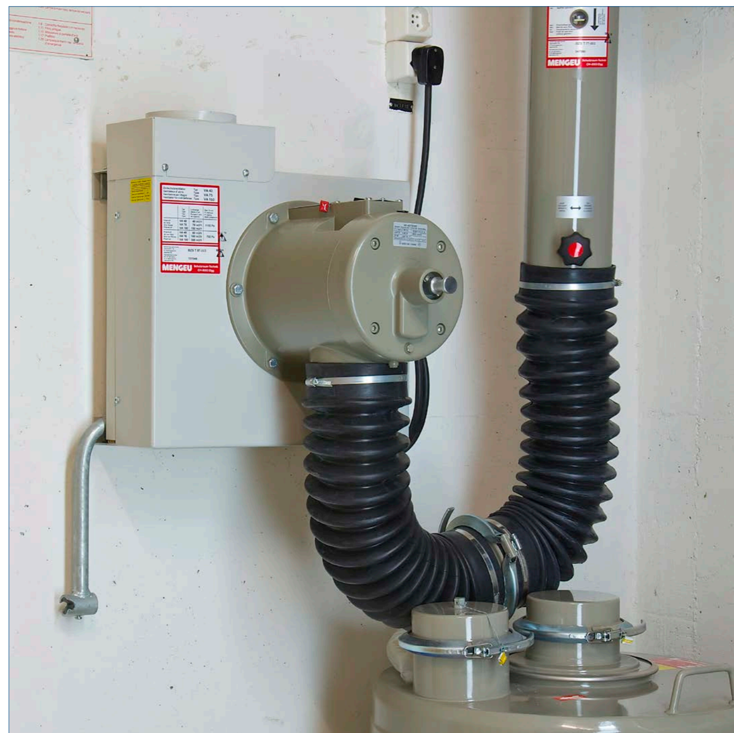
Abb 1: In Schutzraum installiertes VA 40/75/150
