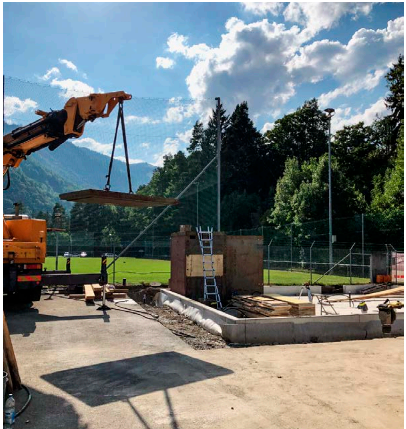
Der Zusammenbau der Messkammer erfolgte mit einem Schwerlastkran. Im Bild wird ein Stahlelement der Decke der Kammer gehievt.
